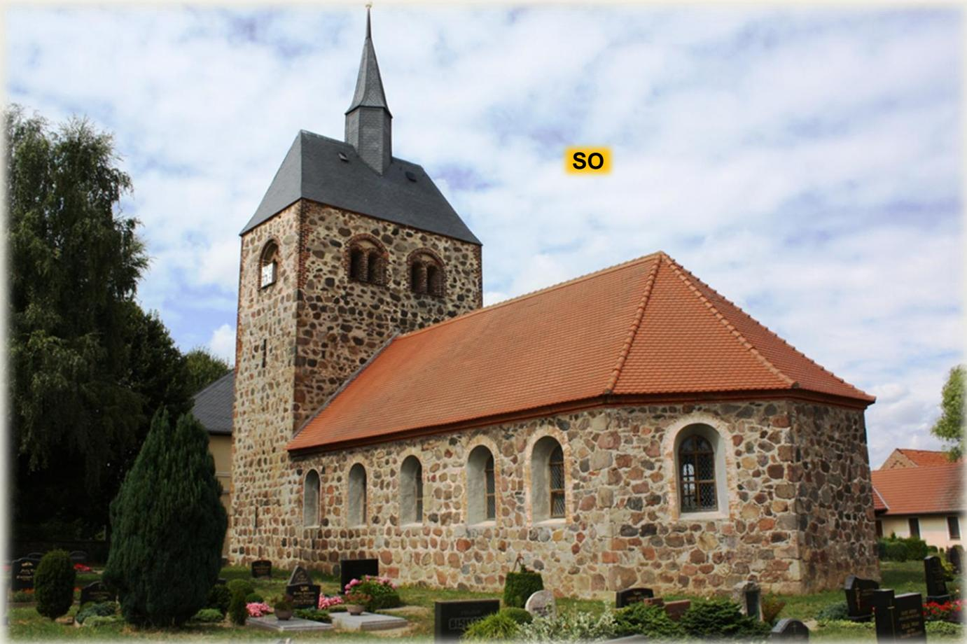
Der Autor geht davon aus, dass mit dem Bau der Kirche aus (heute) lang gestrecktem Schiff, dreiseitigem Ostschluss und Querturm, in der Mitte des 12. Jh. begonnen wurde. Stilistische Kennzeichen sind besonders das bauzeitliche Westportal mit romanischen Kämpfern sowie das kleine Fenster in der westlichen Nordwand.
