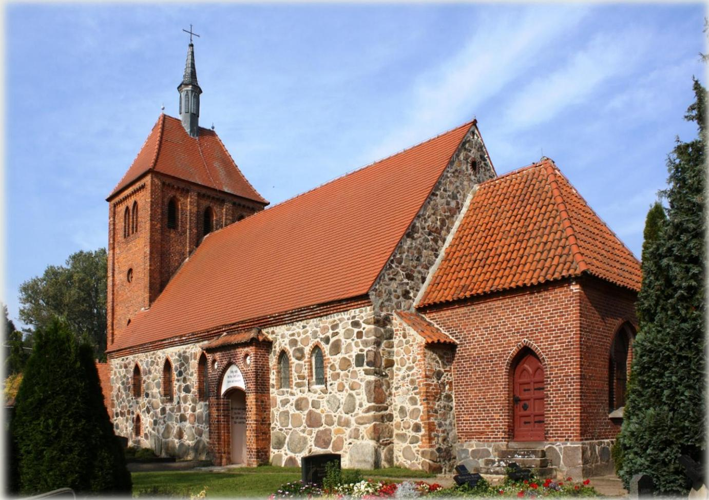
Das Langhaus der Kirche ist nach Ansicht des Autors noch im 13. Jh. errichtet worden. Besonders die Struktur der Nordwand scheint darauf hinzuweisen. Um 1870 hat man den Bau nach Westen verlängert und mit einem quer gestellten Turm aus Backstein abgeschlossen. Er trägt einen zierlichen, verschieferten Dachreiter. Etwa 40 Jahre später wurde der Ostanbau aus Backstein errichtet. Die beiden östlichen Fenster in der Südwand könnten aus der Bauzeit stammen.
